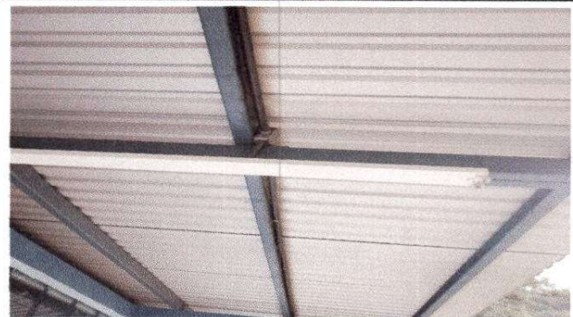
Sustitución de lamparas tipo LED
