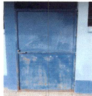
Mantenimiento a estructura
