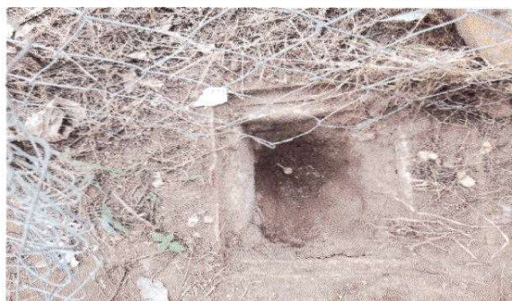
Sustitución de caja de registro
