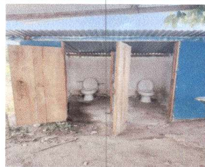
Sustitución de puerta en servicios sanitarios
